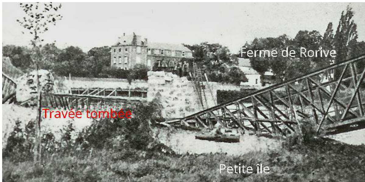
Le pont métallique détruit
